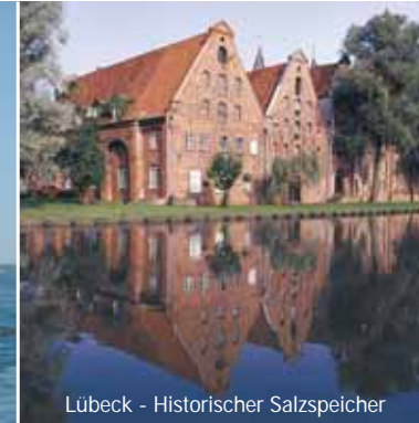
Lübeck - Historischer Salzspeicher
